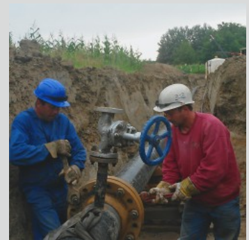
Einbringung in Gasleitung
