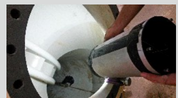
MTA Pipe-Inspector Entnahme bei Francis Turbine
